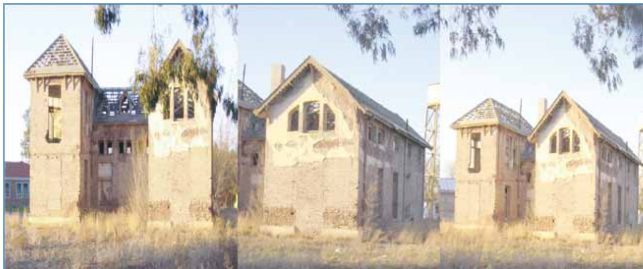
Imagen de edificios del hospital de Allen – Agosto del 2011
